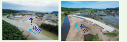
堤防決壊状況(柳橋上流) 護岸施工状況(柳橋上流)
